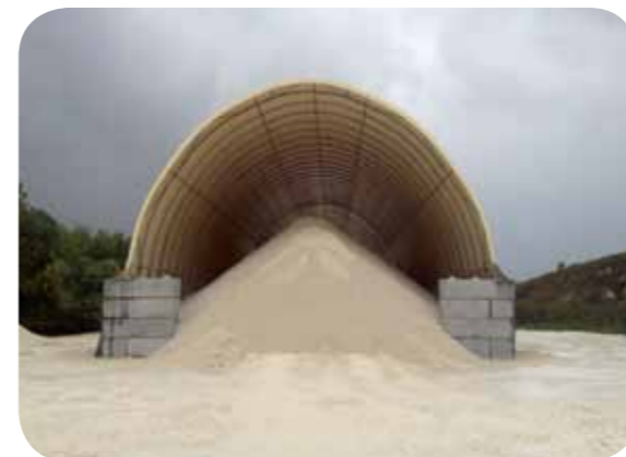
Abri sur muret
